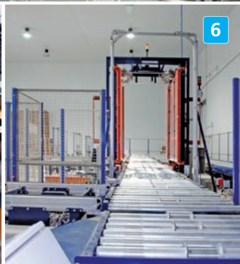
Nell'area di ricevimento e di spedizione, la movimentazione della merce viene effettuata automaticamente.
