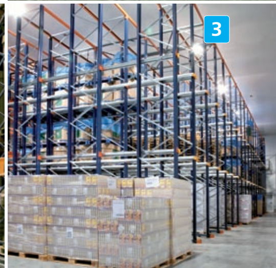
Le scaffalature drive-in consentono di immagazzinare prodotti monoreferenza che resteranno stoccati a lungo.
