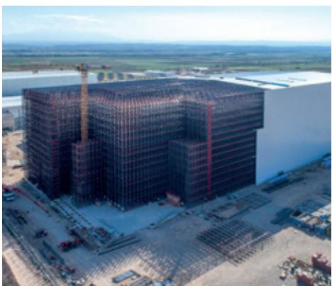
MASSIMA ALTEZZA DI COSTRUZIONE: SI POSSONO COSTRUIRE MAGAZZINI AUTOPORTANTI A PARTIRE DA 12 METRI FINO A 45 METRI DI ALTEZZA.
