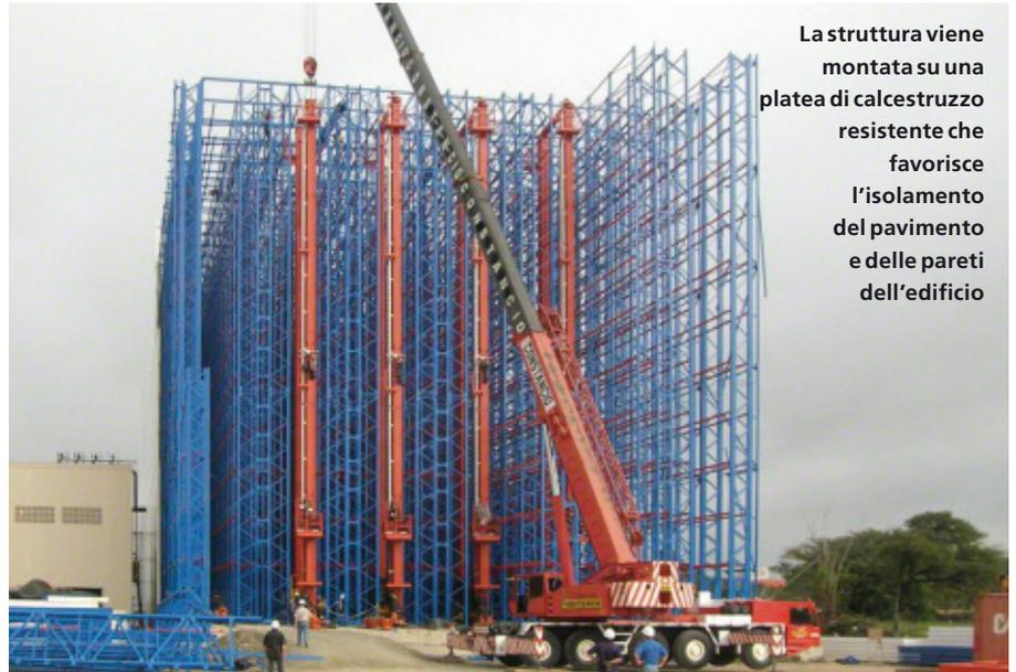
La struttura viene montata su una platea di calcestruzzo resistente che favorisce l'isolamento del pavimento e delle pareti dell'edificio
