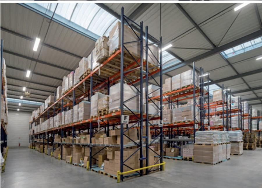
In Francia, il produttore di alimenti per animali domestici Royal Canin ha un magazzino dove Mecalux ha installato un sistema di scaffalature portapallet. Ai livelli inferiori di una parte delle scaffalature sono stati installati canali a gravità per effettuare il picking dei prodotti più piccoli. Analogamente, il magazzino è dotato di un'area di consolidamento completa, formata da un gruppo di trasportatori.
