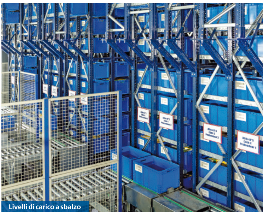
Area posteriore del magazzino
