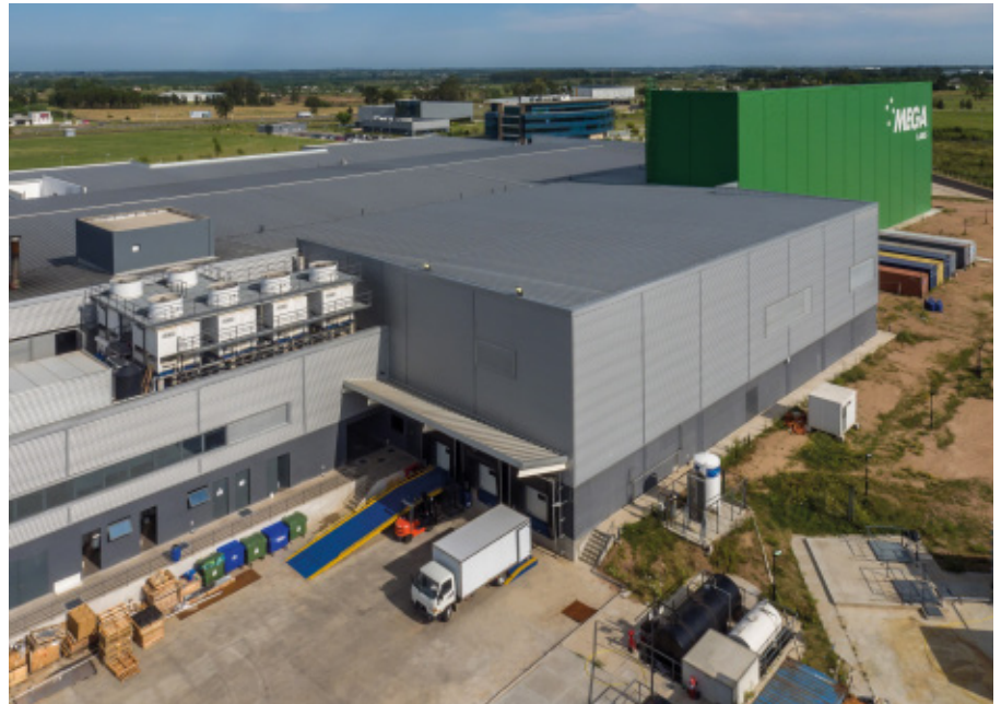
Le baie di carico e scarico sono separate, per evitare interferenze tra i cicli operativi
