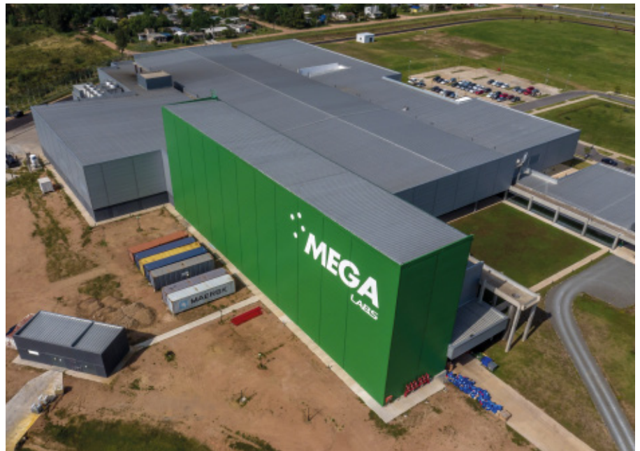
Il magazzino di Mega Pharma è predisposto alla crescita, qualora le prospettive di espansione dell'azienda lo richiedano
